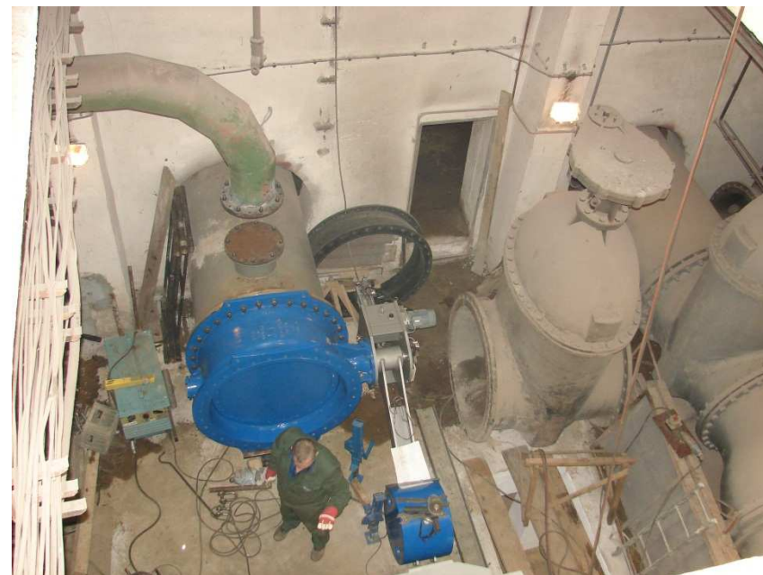
Instalacja EKN DN 1200 HB-HV
