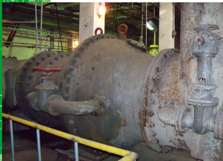
Przed modernizacją zawór wieloklapowy
