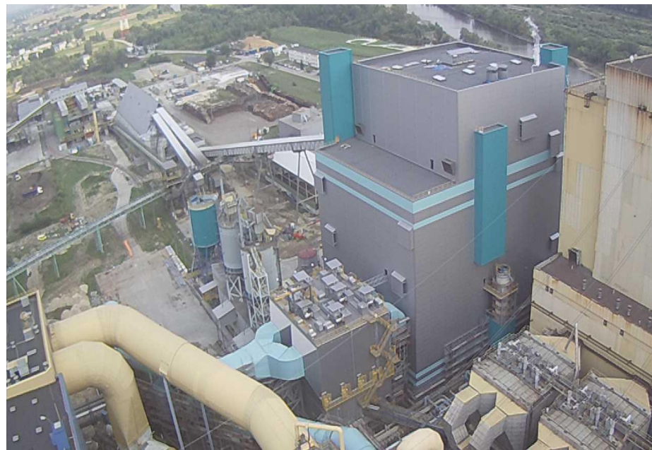
Widok z kamery na Instalację Zielonego Bloku - wrzesień 2012
