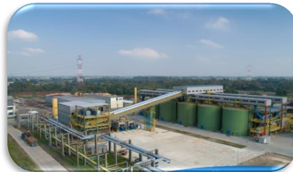
Instalacja do rozładunku i magazynowania biomasy Agro
