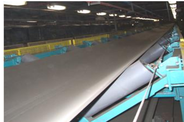
T55 - światłowodowy kabel sensoryczny
