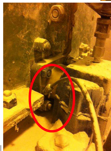
Uszczelnienie LabTecta-IAP™ po 3 dniach
