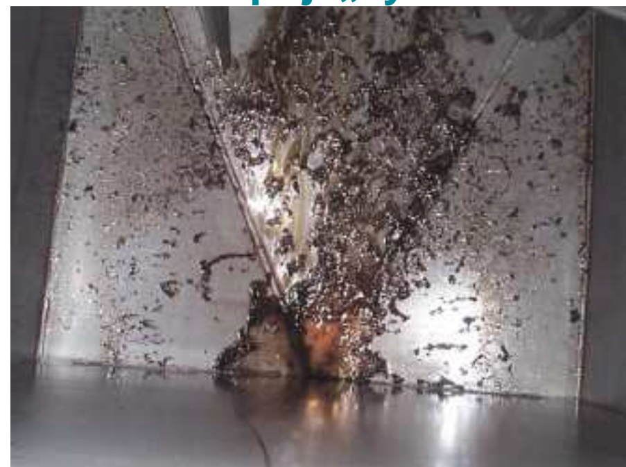
„Żywice” pozostałe po filtrze pełno przepływowym
