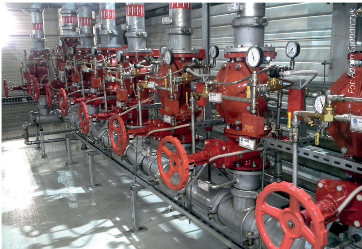
POMPY wody przeciwpożarowe
