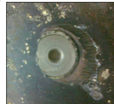
Zabudowana dysza na kanale gorącego powietrza
