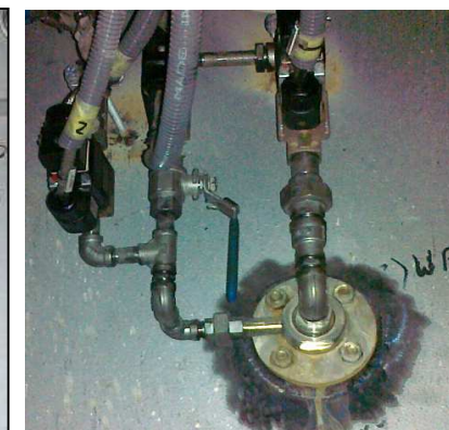
Instalacja podawania azotu i wody do dyszy – komora mielenia, przestrzeń zgarn
