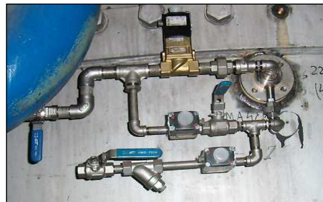
Instalacja podawania azotu i wody do dyszy – komora mielenia, przestrzeń zgarn
