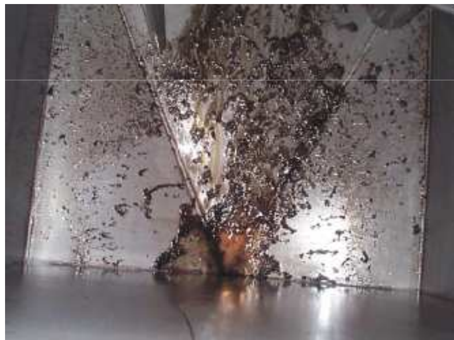
„Żywice” pozostałe po filtrze pełno przepływowym
