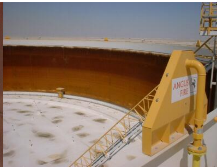
Liniowy detektor temperatury uruchamia pianę
